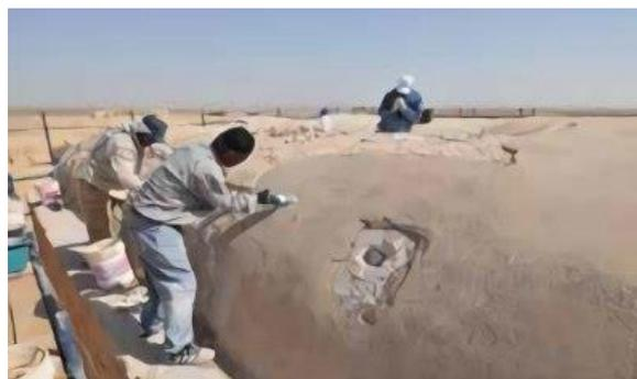
Рис. 6. Нанесение слоев известкового раствора на внешние поверхности сводов
