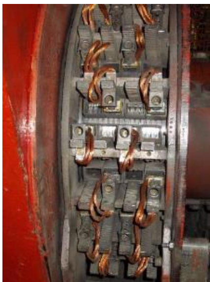
Рис. 1. Щеточно-контактный аппарат ТВВ-320-2У3
