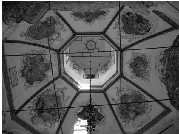
Рис. 2. Вид на свод. Церковь Спаса Преображения (1748–1754 гг.) дер. Слобода, Лузский р-н, Кировская обл.
