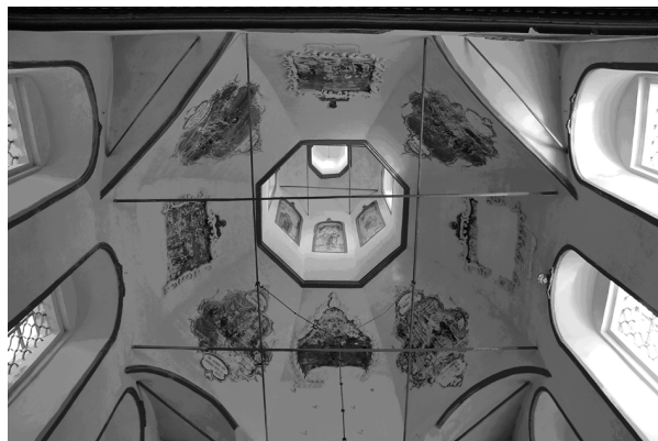
Рис. 3. Вид на свод. Церковь Богородицы (1763 г. – XIX в.) дер. Озёрская, Лузский р-н, Кировская обл.
