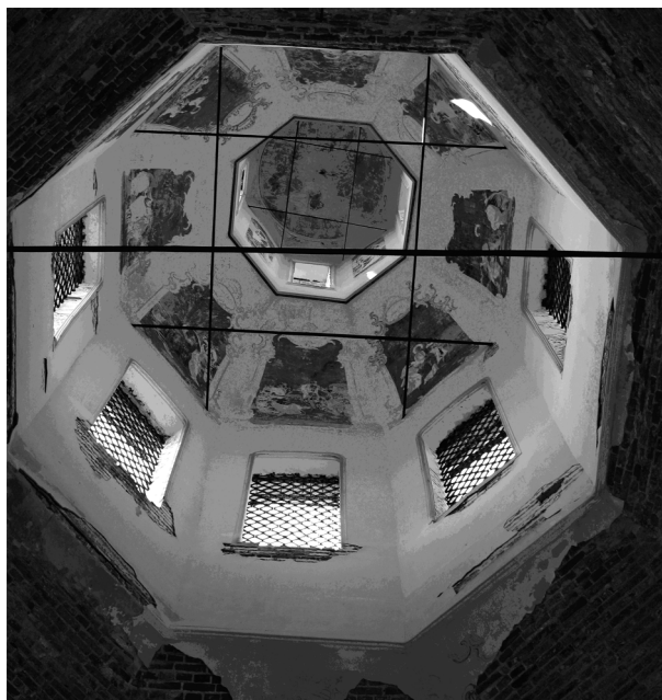
Рис. 1. Вид на свод.
